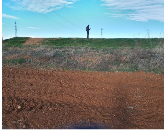
Foto 4.- Resalte entre la terraza 27, y la terraza 26. Vista hacia el NW.
