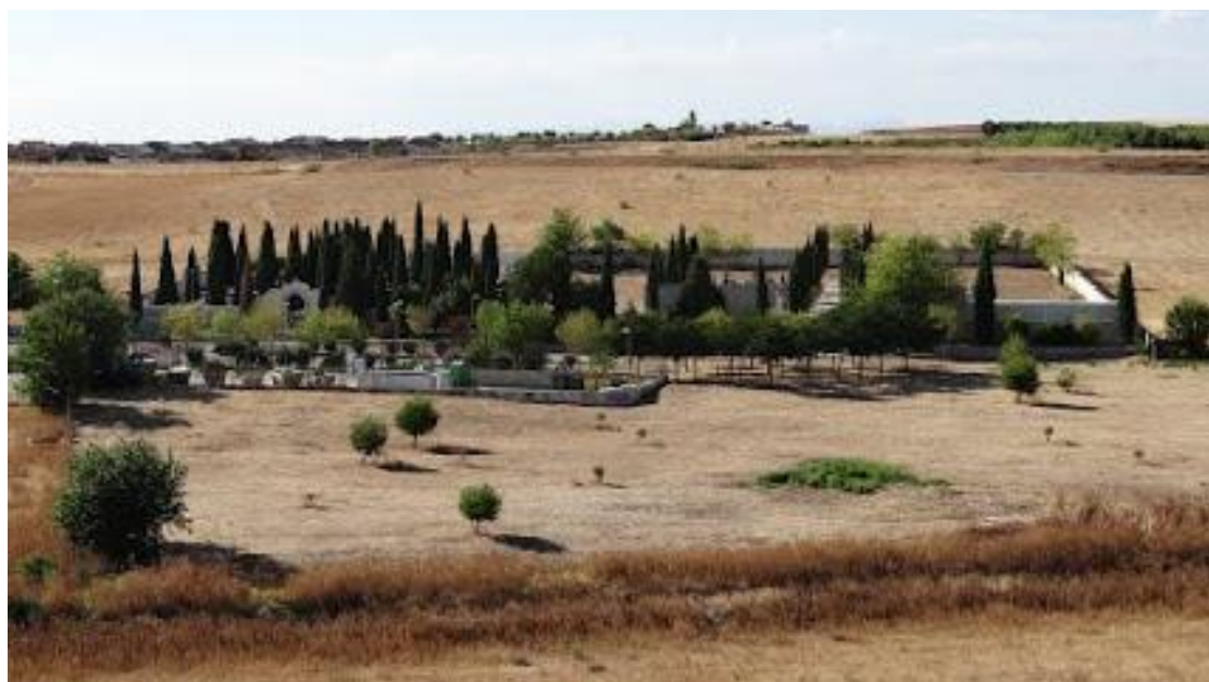
Fotografía aérea del Punto limpio en la localidad de Meco.
