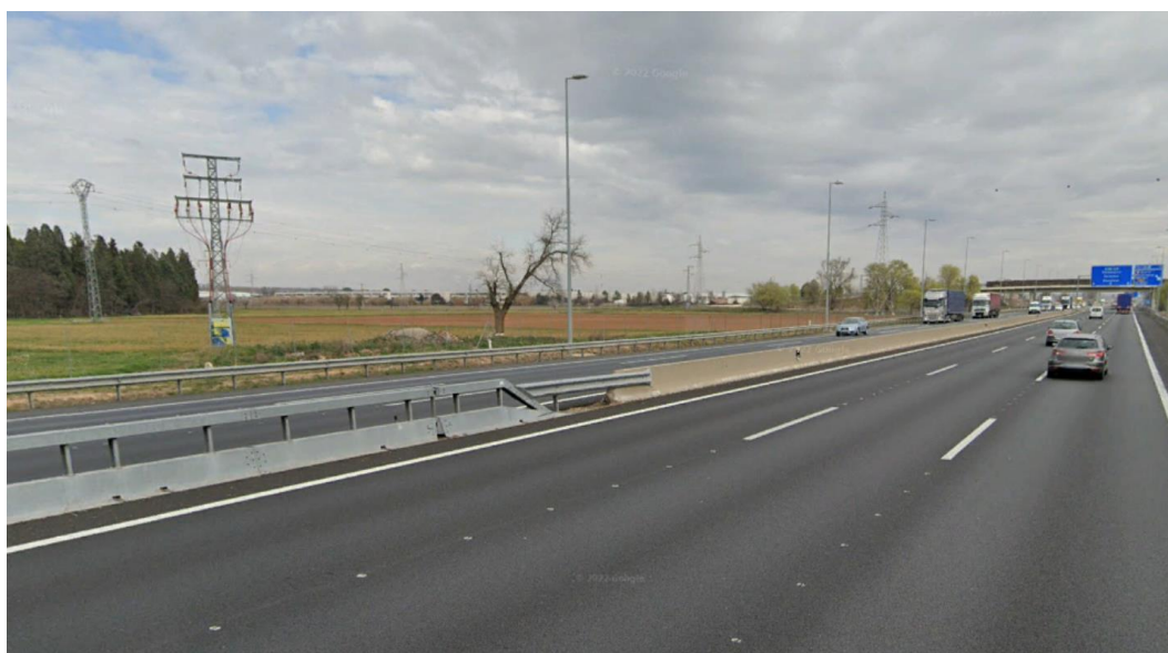
Autovía A-2 en el P.K. 37 mirando hacia el ámbito del Plan de Sectorización
