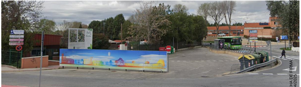
Figura. Estado actual del área. (Fuente: Google Maps)
