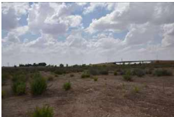
Puente de paso de la M-121 sobre la R-2 y depósitos de abastecimiento de agua potable.
